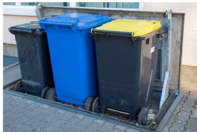
*Beispiel für einen versenkbaren Behälterstandplatz mit Zweirad-Behältern*
